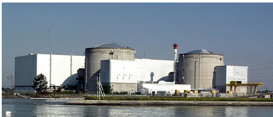
Centrale nucléaire de Fessenheim (Haut-Rhin)
