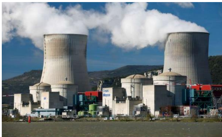
Centrale nucléaire de Cruas – Meyssac (Ardèche)
